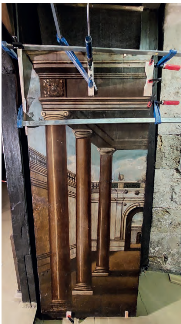
7. attēls. Durvju vērtnes plaisu un koka ielaidumu līmēšanas process ar līmspilēm, foto Aigars Pilenieks
