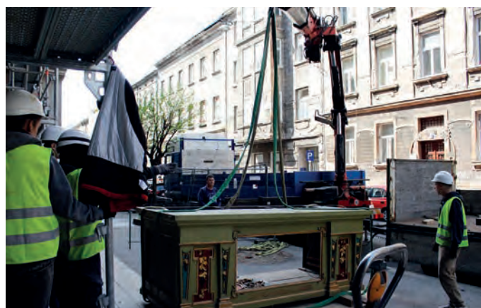
5. attēls. Altāra arhitektūras daļas transportēšana ar celtni kravas automašīnā, foto Maja Sučević Miklin / Image 5. Transporting the altar's architecture with a crane on a truck, photo Maja Sučević Miklin
