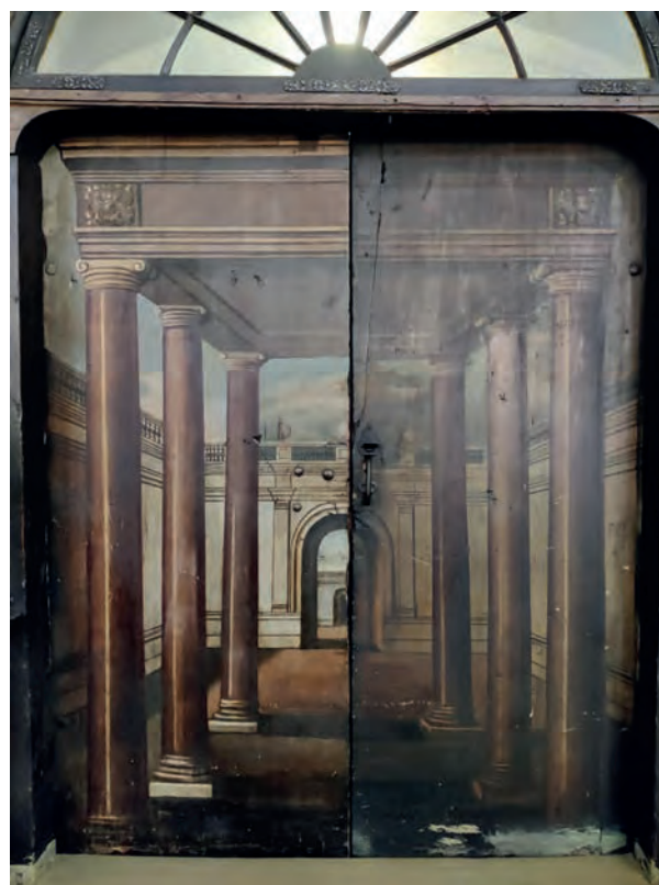
8. attēls. Skats uz durvju vērtņēm restaurācijas procesā, foto Ronalds Lūsis, Rīgas Doma pārvalde
