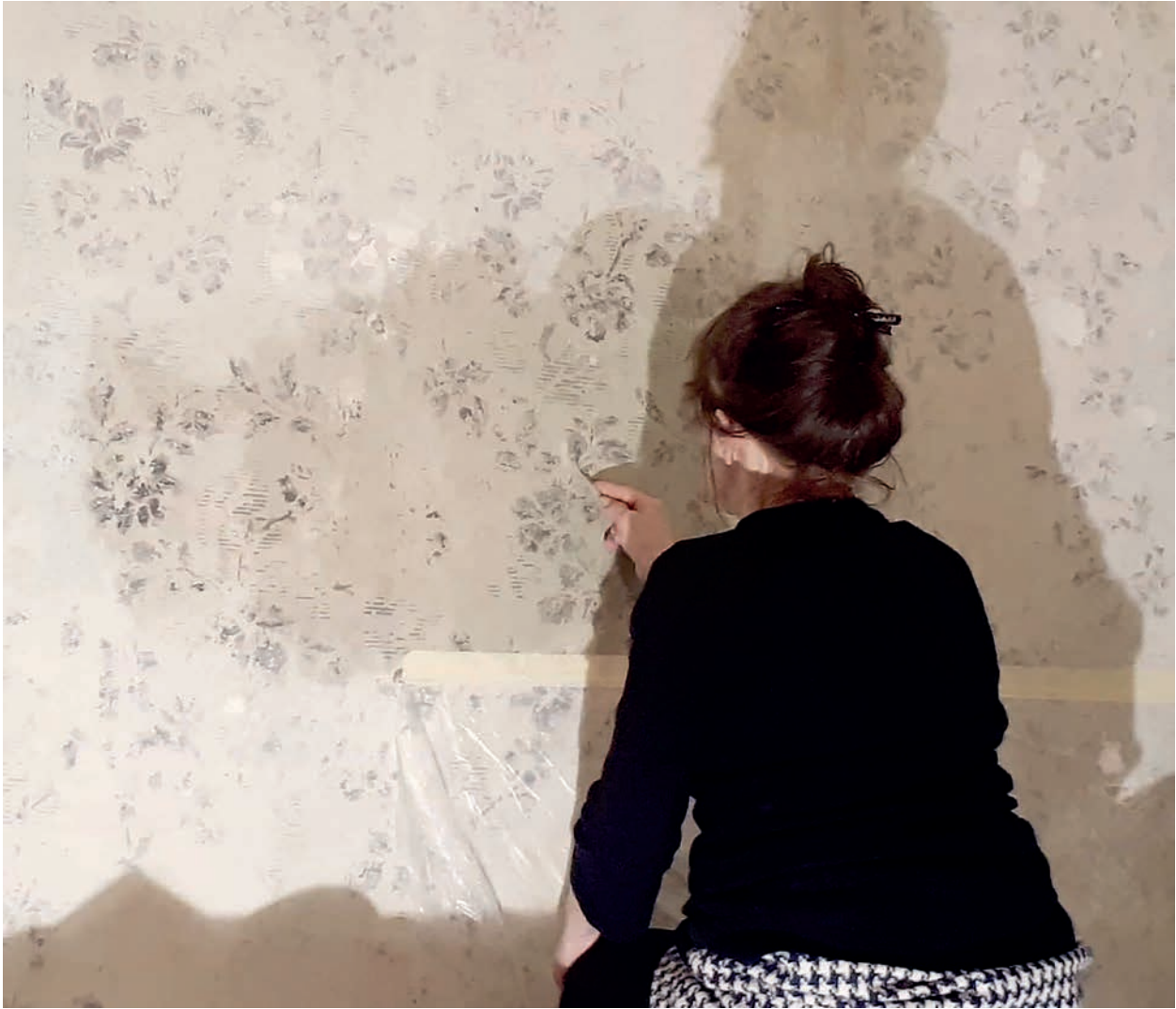
1. attēls. Privāts pasūtījums telpas trafareta (20. gs.s.) restaurācijai / Image 1. Private commission for the restoration of wall stencil
