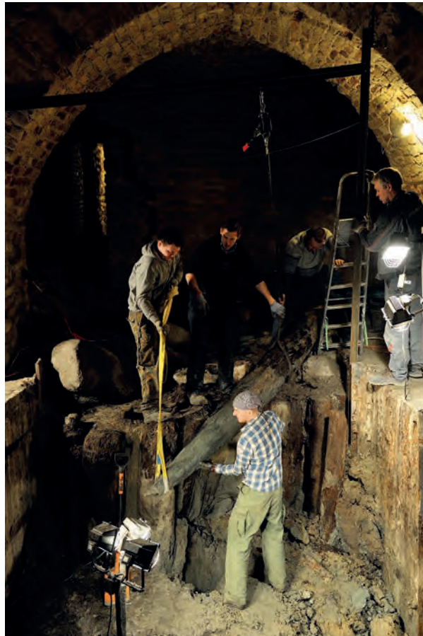
1. attēls. Pāļi in situ / Image 1. Piling in situ
