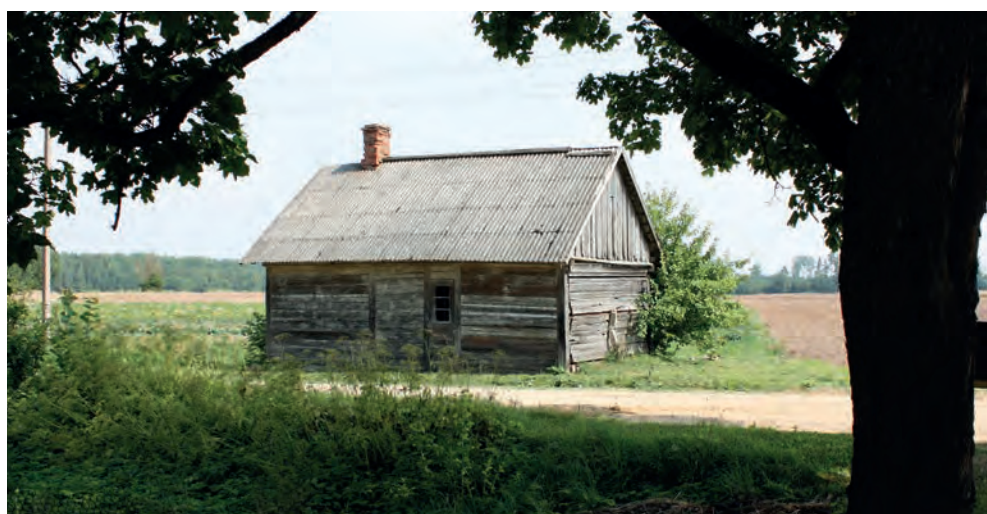
2. attēls. Vecgaiķu kalte 1937. gadā uzbūvēta no 18. gadsimta muižas ēkas būvmateriāliem / Image 2. The drying kiln of Vecgaiķi, built in year 1937 from an old manor building constructed in the early 18 th century
